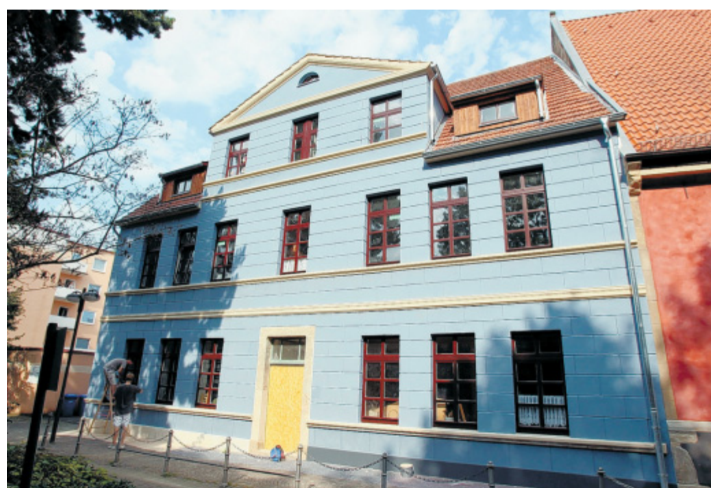
Lebendiges Blau: An den Farbton haben sich der Restaurator und Pfarrer Johannes Beer mit zahlreichen Proben herangearbeitet. Die Gesimse sind in Ocker abgesetzt, Fenster und Tür in Braun. FOTO: KIEL-STEINKAMP
